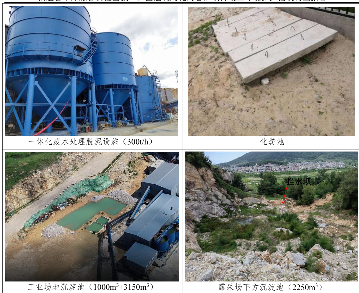
图 6.2-4 废水治理设施现状照片
