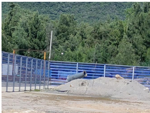
移动喷雾机及成品堆场防风挡墙
