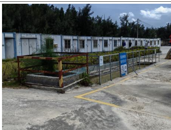
洗车水沉淀池（28m 3 ）
