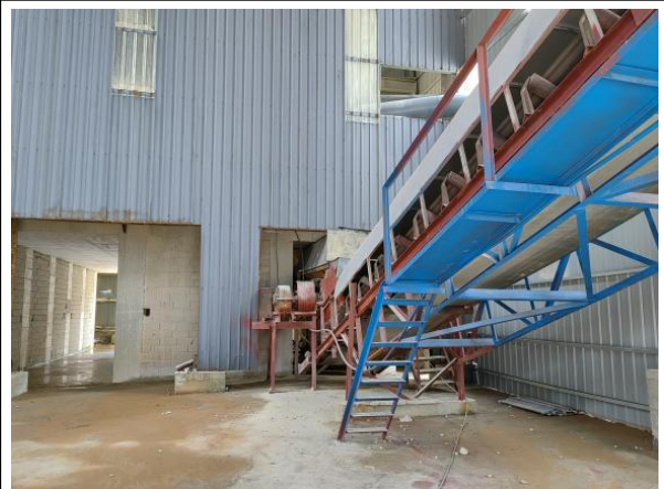
输送皮带封闭
